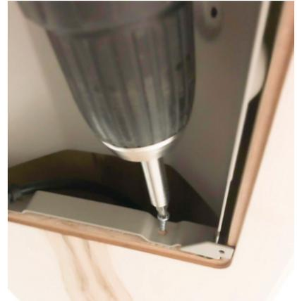
Achten Sie darauf, dass bei senkrecht montierten Infrarotstrahlern der Anschluss immer unten ist! Wenn Sie Systemkabel verwenden, können Sie diese bereits jetzt fest miteinander verbinden. Achten Sie dabei immer darauf, dass sich die Steckverbindung nicht versehentlich lösen kann. Verwenden Sie eventuell eine Zugentlastung.
