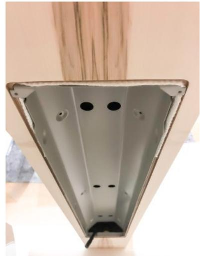
Per montare il radiatore a infrarossi a filo, è possibile rimuovere il legno dove si trovano le linguette metalliche.
